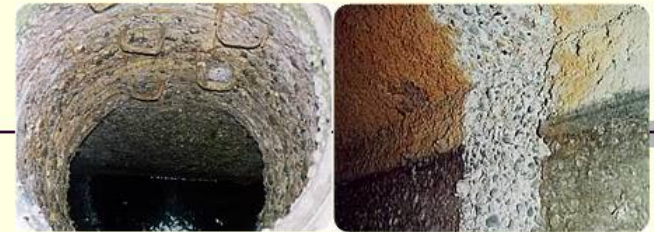
Fig. 1. Dégradation due à l'attaque d'acide sulfurique biogène dans l'espace libre d'une canalisation d'eaux usées
